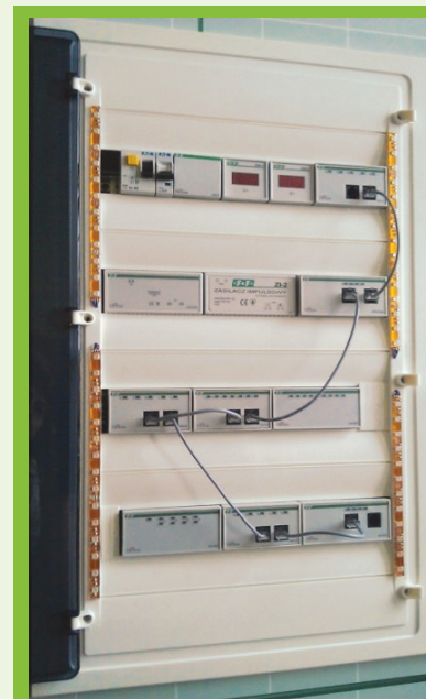
Шкаф с модулями системы F&Home
